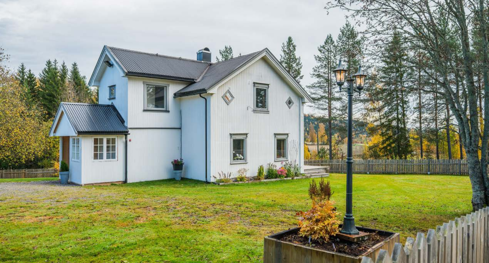
Opprinnelig bygning med tømmerlaft, laftetømmer innvendig og utvendig påforet. Tilbygget fremstår å være oppført med reisverk evt bindingsverk. Fasader med stående kledningsbord.
