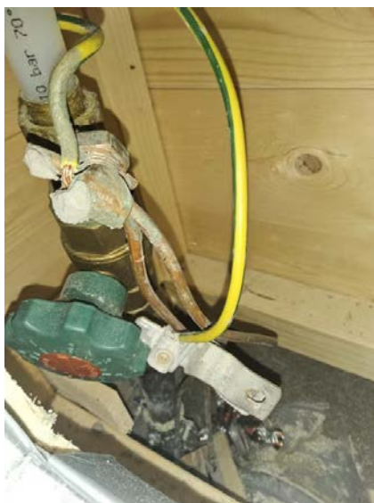
Hovedstoppekran er tilgjengelig via inspeksjonsluke på bad.
