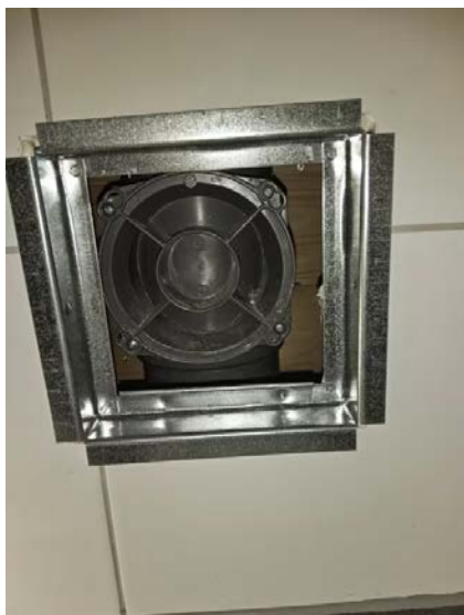
Stakeluke er tilgjengelig via inspeksjonsluke på bad.
