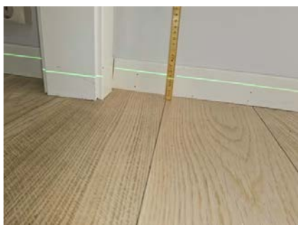
Etasjeskille er kontrollert med nivelleringslaser.
