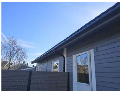
Det er etablert nye takrenner og nedløp i 2025.
