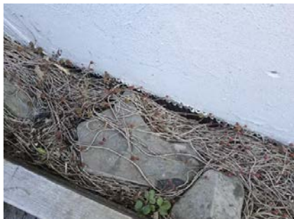
Stedvis synlig fuktsperre mot grunnmur.
