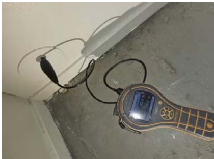
Bilde fra fuktmåling i utlektet veggkonstruksjon.
