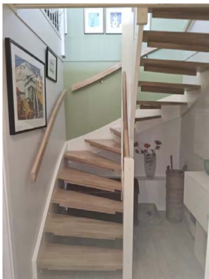
Åpen trapp av tre mellom etasjene.
