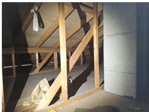
Uinnredet kaldloft over boligen.
