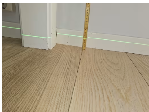
Etasjeskille er kontrollert med nivelleringslaser.
