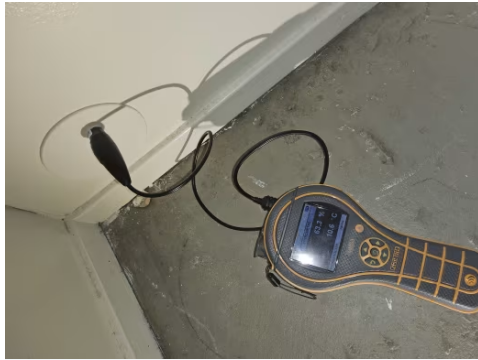
Bilde fra fuktmåling i utlektet veggkonstruksjon.
