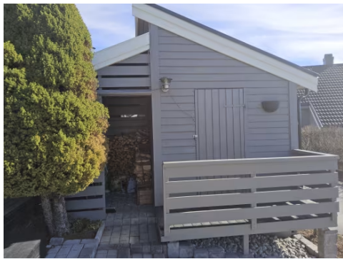
Frittstående utebod med vedskjul.
