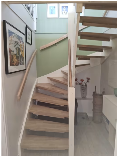
Åpen trapp av tre mellom etasjene.
