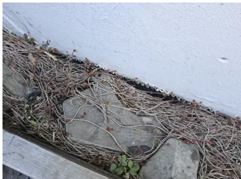
Stedvis synlig fuktsperre mot grunnmur.
