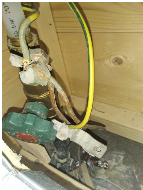
Hovedstoppekran er tilgjengelig via inspeksjonsluke på bad.
