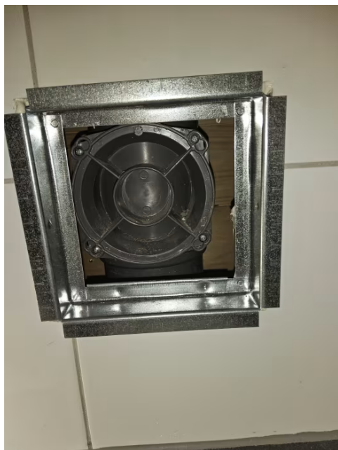
Stakeluke er tilgjengelig via inspeksjonsluke på bad.
