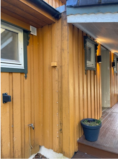
Råteskade kledning
