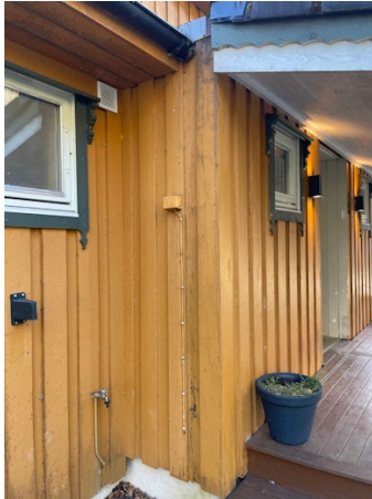
Råteskade kledning
