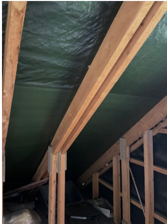
Undertak av plast/presening
