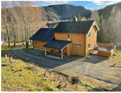
Manglende rekkverk
