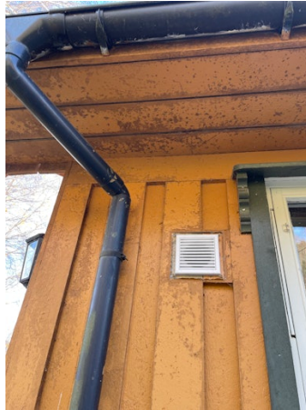
Misfarging/svertesopp kledning
