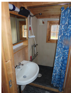
Enklere dusjbad med porselensservant og dusjnisje med forheng.
