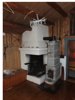
Murt teglsteinspipe ført ned til større murt gruepeis i opprinnelig del. Frittstående klebersteinsovn.
