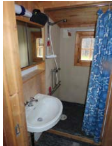
Enklere dusjbad med porselensservant og dusjnise med forheng.
