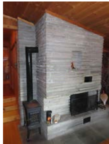
Tilbygd del med større murt gruepeis i liggende Oppdalskifer. Frittstående vedovn.
