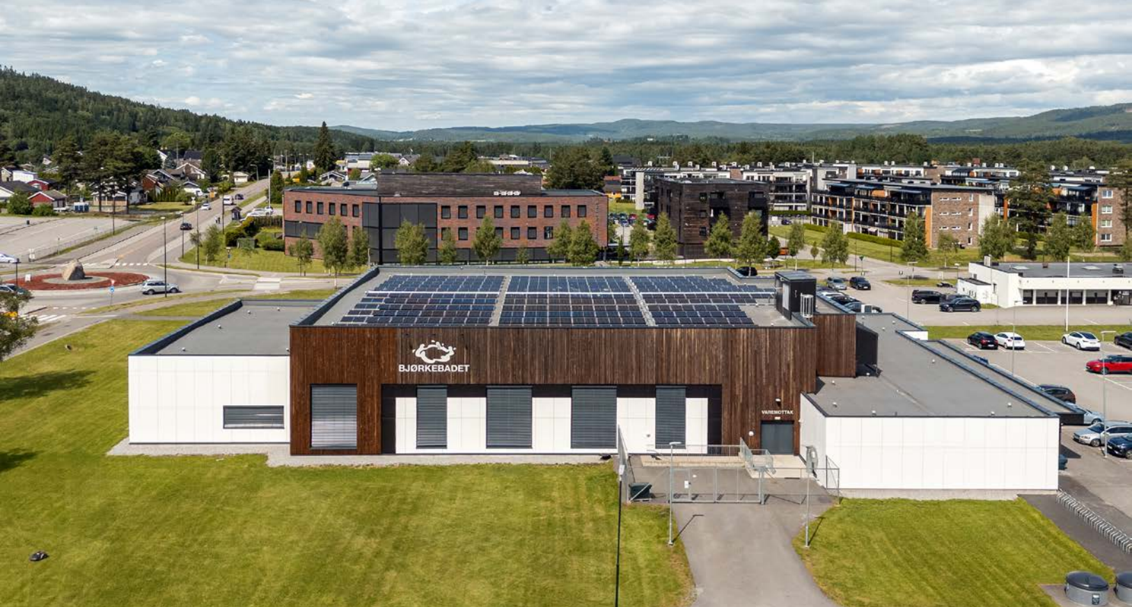
Bjørkebadet ligger i sentrum og ble åpnet i 2018 og tilbyr bl.a. 25-meters basseng, terapi- og plaskebasseng samt boblebad, kaldkulp og badstuer. Helsehuset rommer bl.a. legevakt, legekontor og tannhelsetjeneste.
