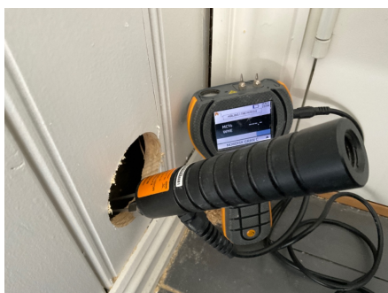
Fuktmåling i vegg ved hulltaking.
