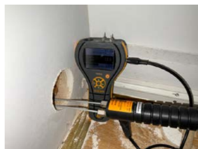
Fuktmåling i vegg ved hulltaking.
