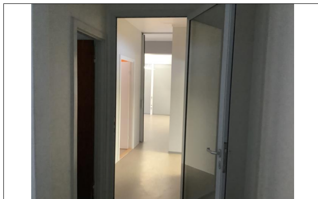
Nyere metalledører i 2. etg.
