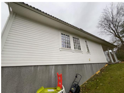
Bordkledning avsluttet nærme terrenget.
