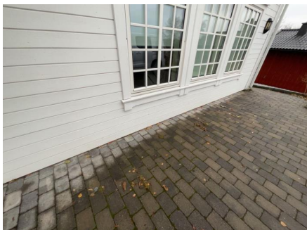
Bordkledning avsluttet nærme terrenget.
