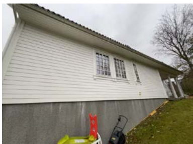
Bordkledning avsluttet nærme terrenget.
