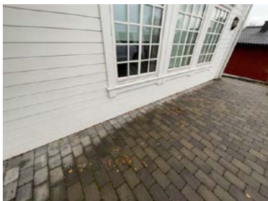
Bordkledning avsluttet nærme terrenget.
