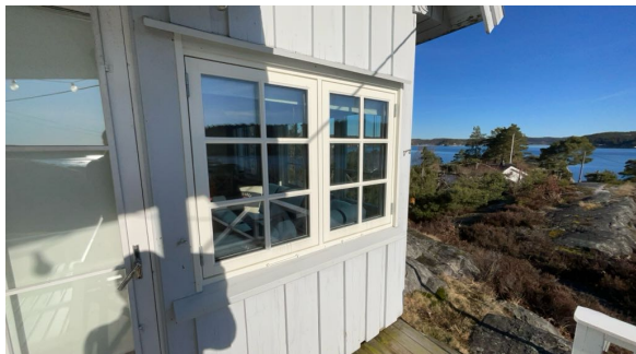
Eksempel på vindu i yttervegg.
