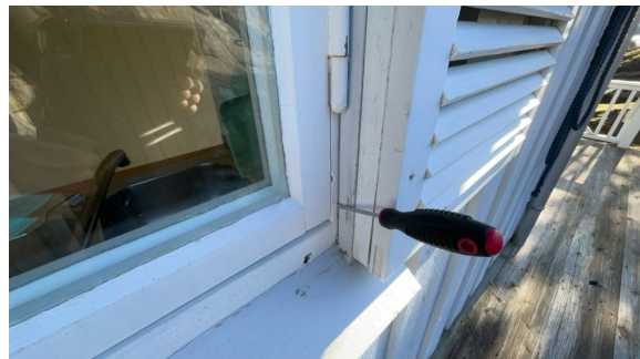
Stikk kontroll på vinduer er utført.
