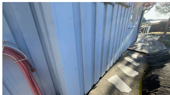
Del av vegg.
