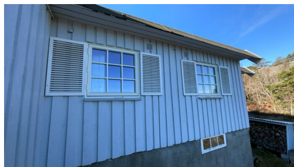
Eksempel på vindu i yttervegg.
