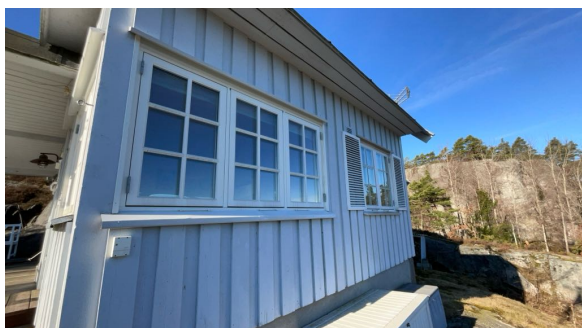
Eksempel på vindu i yttervegg.
