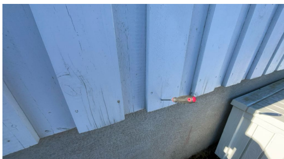
Stikk kontroll av vegger er utført.
