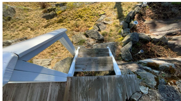
Trapp ned fra terrasse.
