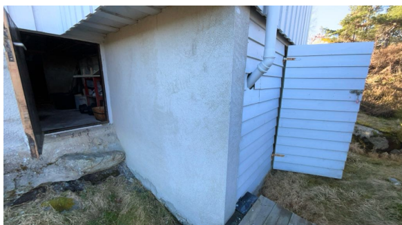
Del av grunnmur.
