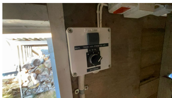
Styre strøm til pumpe.
