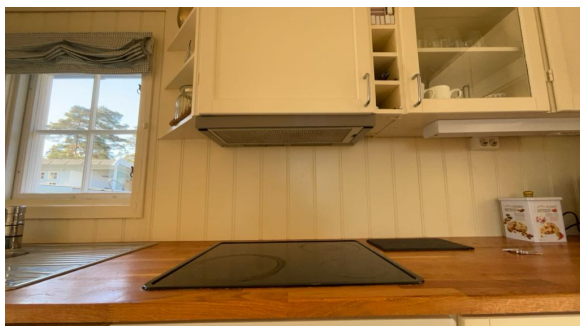
Montert avtrekk over steketopp.
