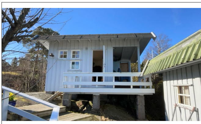
Anneks oppført på eiendommen
