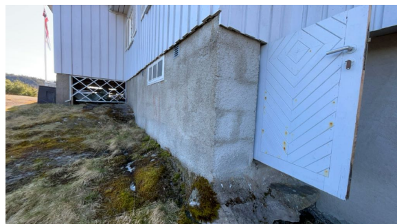
Del av grunnmur.
