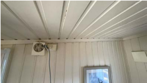
Del av vegg - tak.
