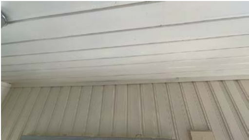
Del av vegg - tak.
