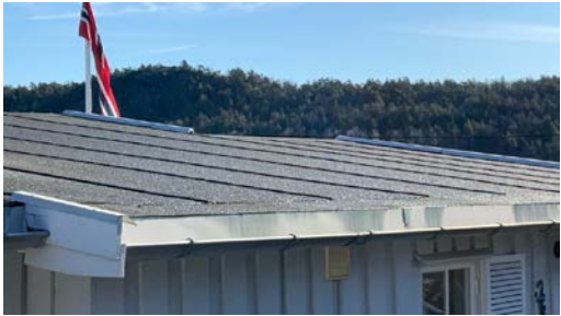
Del av taktekking.
