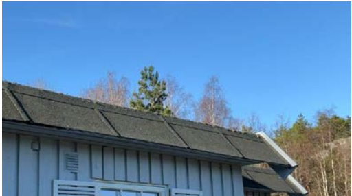
Del av taktekking.
