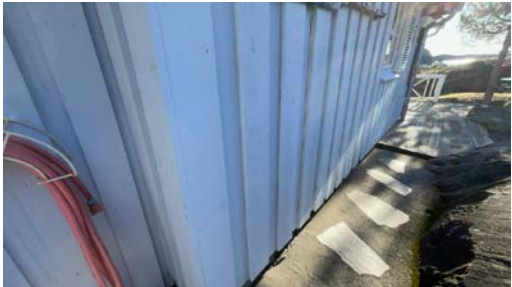
Del av vegg.
