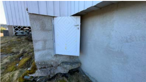
Luke inn til krypkjeller.
