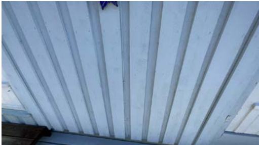
Del av vegg.
