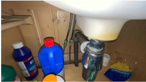
Del av rør til vann.
