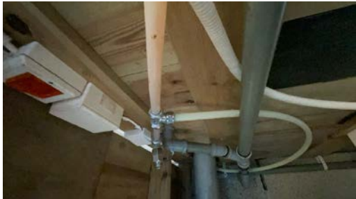
Del av rør til vann.
