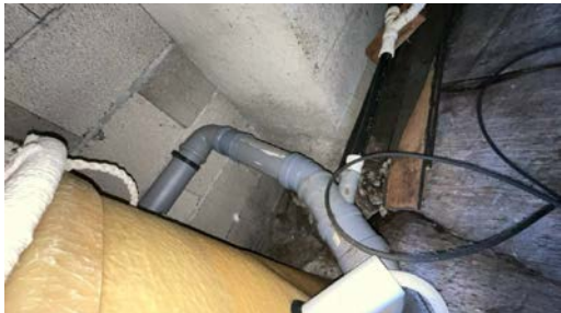
Del av rør til avløp.
