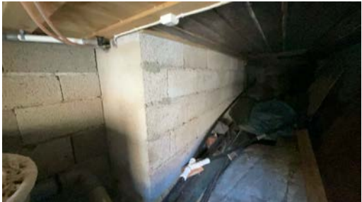
Del av grunnmur.
