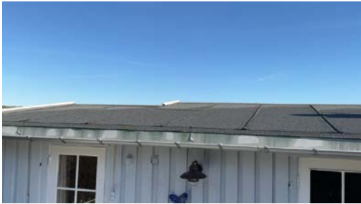
Del av taktekking.
