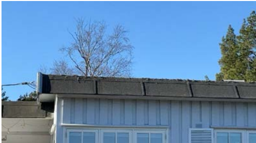
Del av taktekking.
