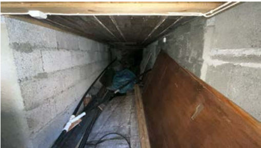
Del av krypkjeller.
