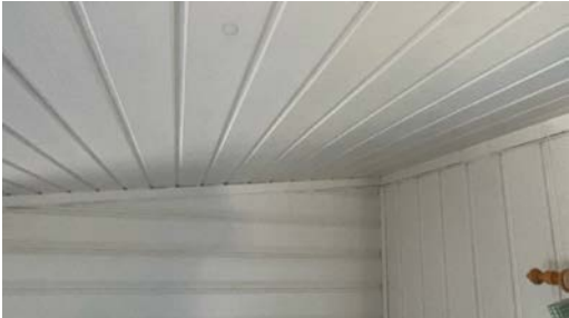
Del av vegg - tak.
