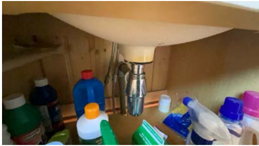
Del av rør til avløp.
