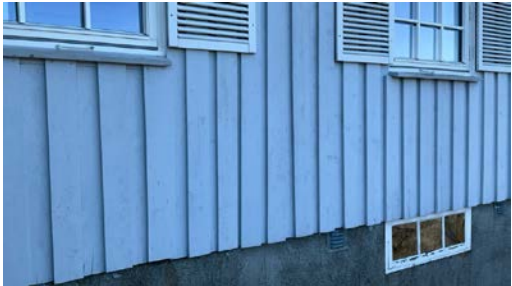
Del av vegg.
