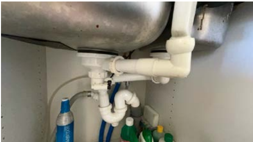
Del av rør til avløp.
