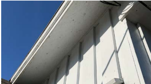
Del av takkonstruksjon.
