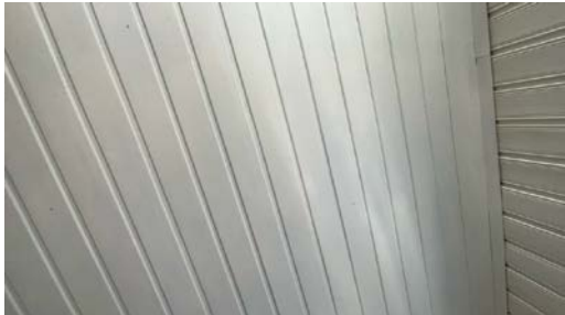
Tak sett fra innsiden.
