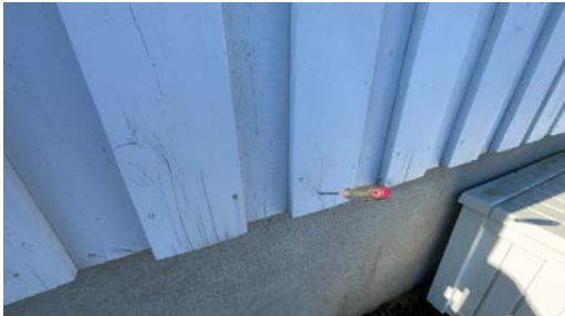
Stikk kontroll av vegger er utført.
