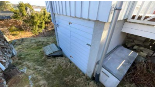
Luke inn til krypkjeller.
