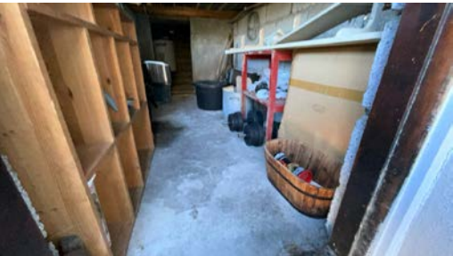
Del av krypkjeller.
