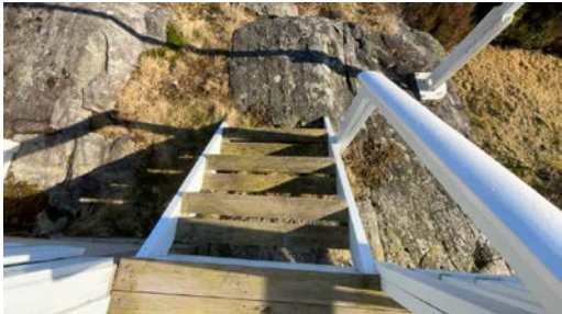
Trapp ned fra terrasse.
