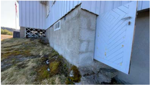
Del av grunnmur.
