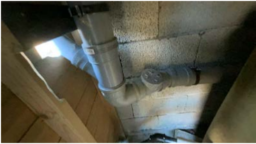
Del av rør til avløp.
