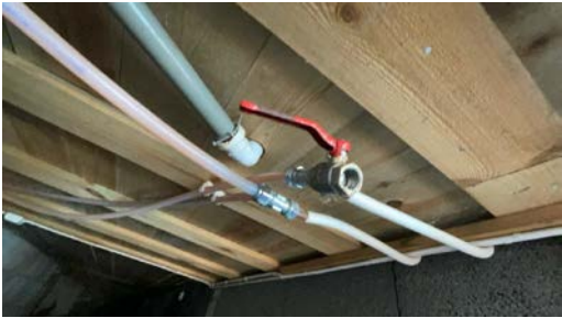
Del av rør til vann.
