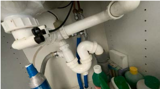
Del av rør til vann.
