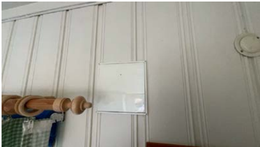
Eksempel på montert ventil i vegg.
