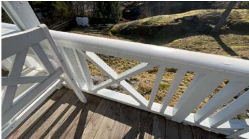
Åpninger i rekkverk er ikke i henhold til krav i dagens forskrifter.
