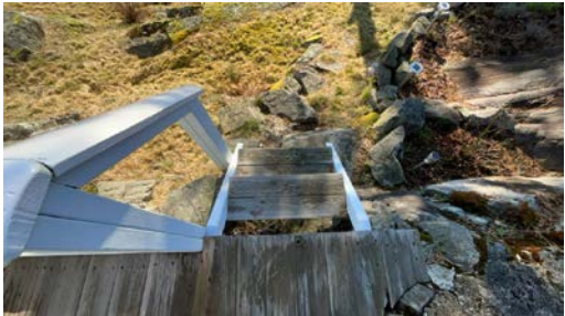
Trapp ned fra terrasse.
