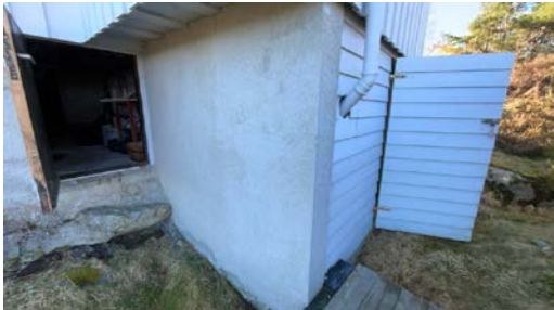
Del av grunnmur.
