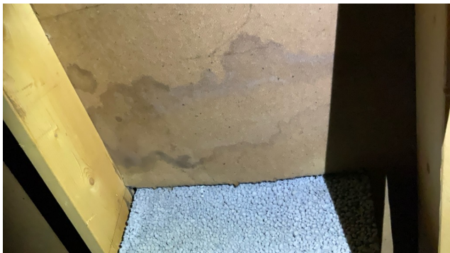
Eksempel på fuktskjolder i undertak ved pipe.
