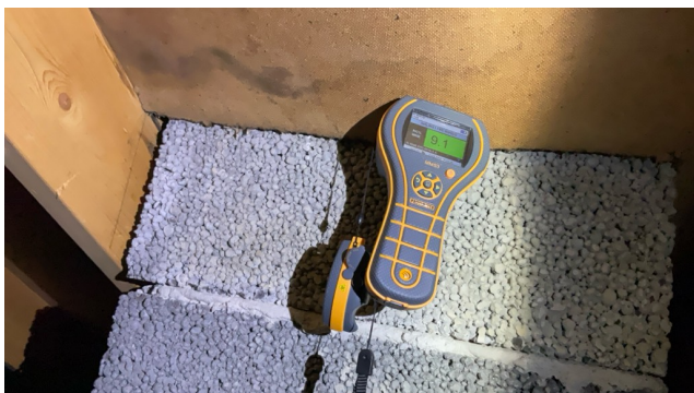
Eksempel på fuktskjolder i undertak ved pipe.
