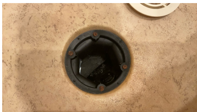
Plastsluk med synlig vinylbelegg.
