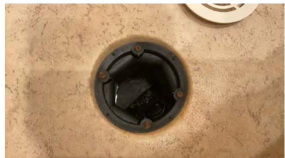
Plastsluk med synlig vinylbelegg.
