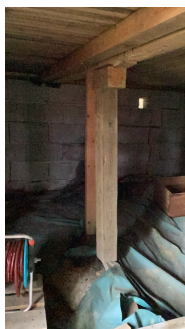
Det er noen understøttelse av tre under bygget
