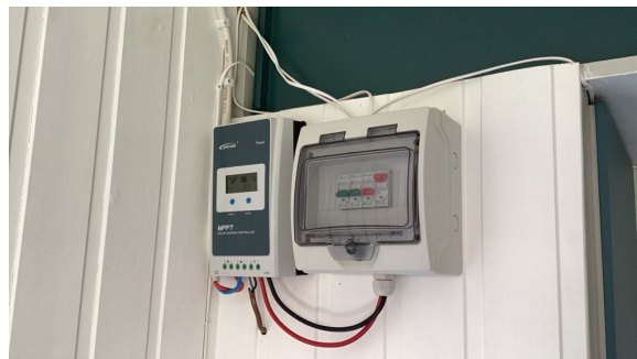
Sikringer på soverom.
