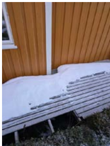
Under terrassen ligger oljetanken
