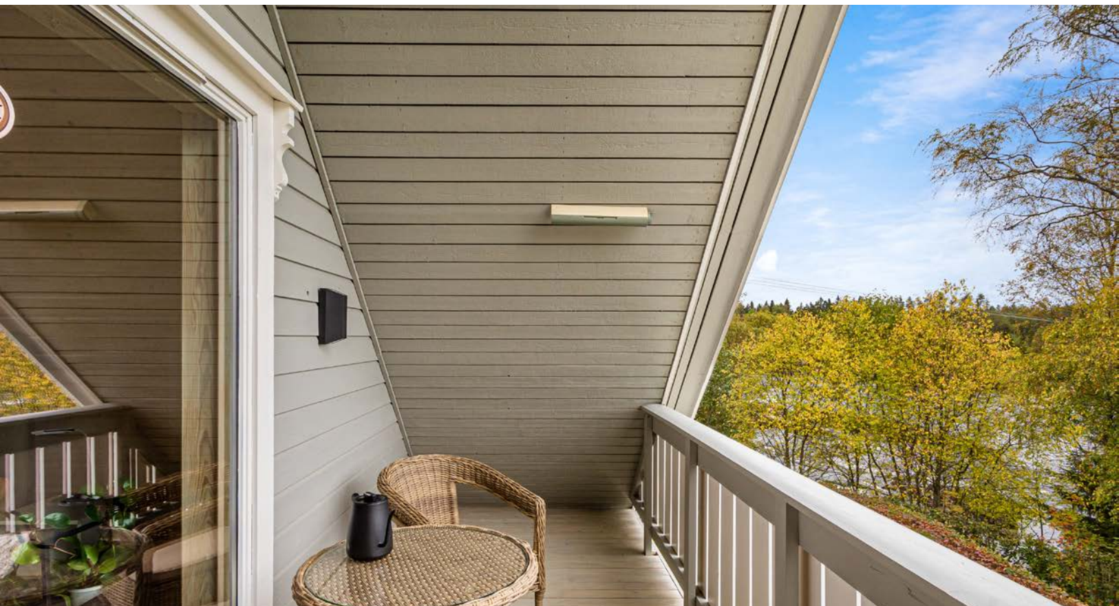
Overbygget veranda 2. etasje.
