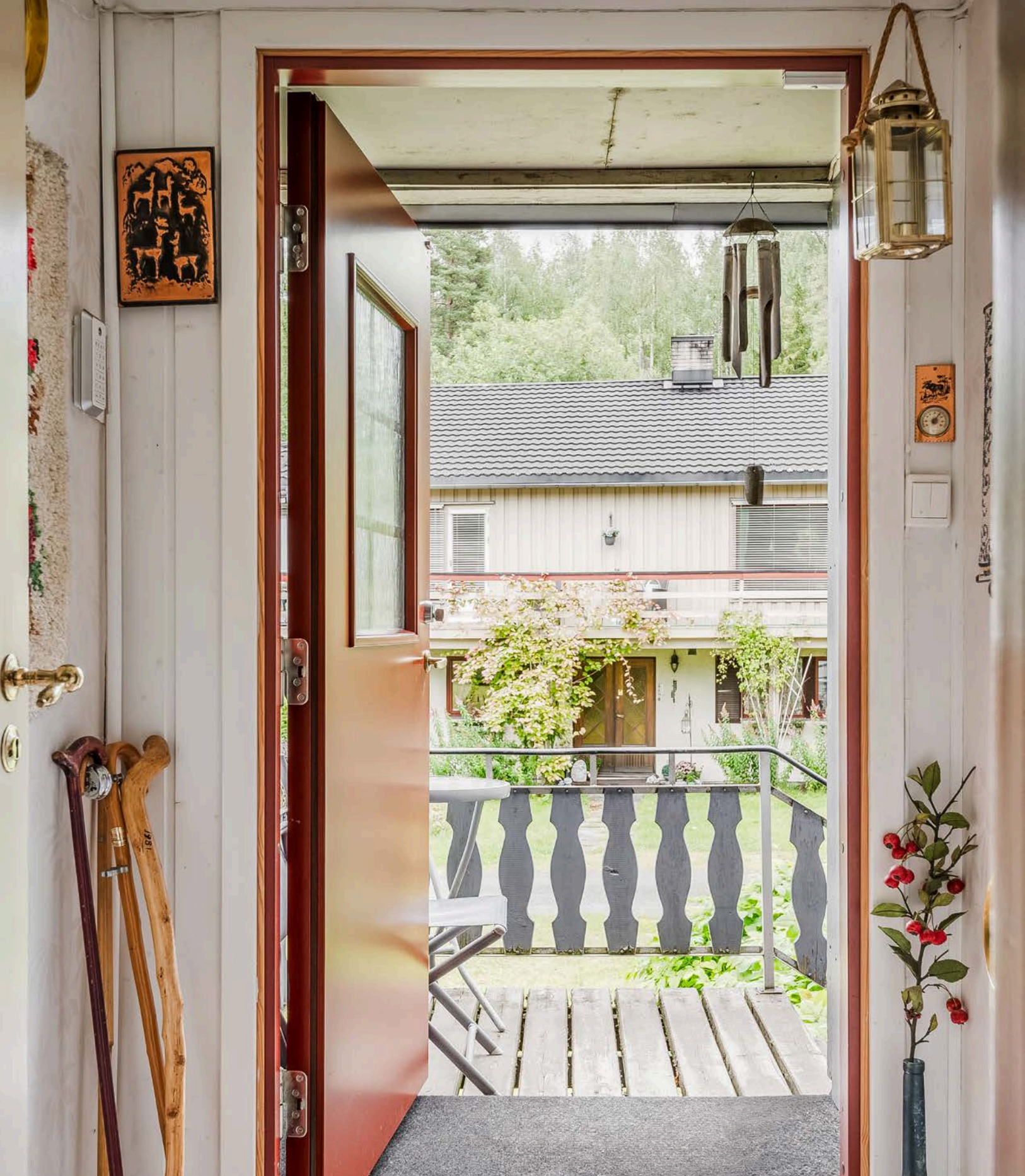
Boligen ansees som et oppussingsobjekt og har behov for oppgraderinger for å tilfredsstille dagens krav til standard.
