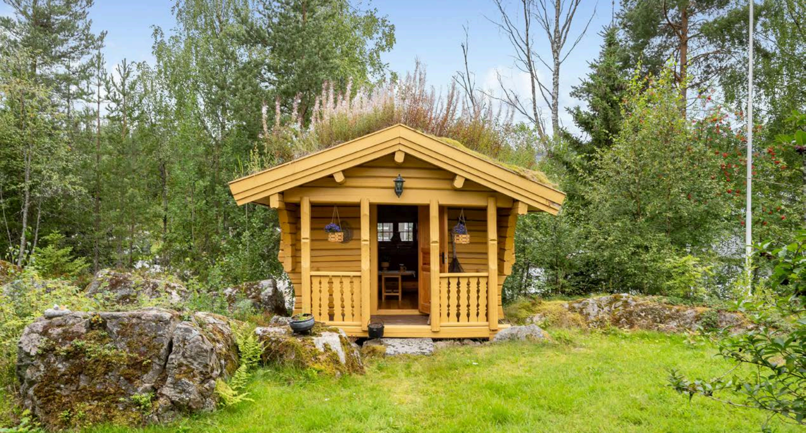
I hagen er det også et koselig stabbur antatt bygget på 1990-tallet. Stabburet har yttervegger av laftet tømmer, åstak og inngang via en liten overbyggt veranda.
