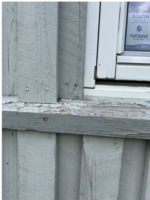
Treverk helt ned til vannbrett.
