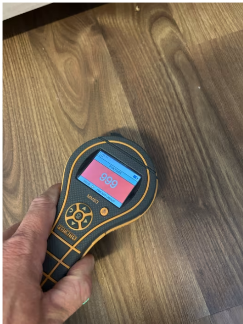
Fuktsøk ved oppvaskmaskin.
