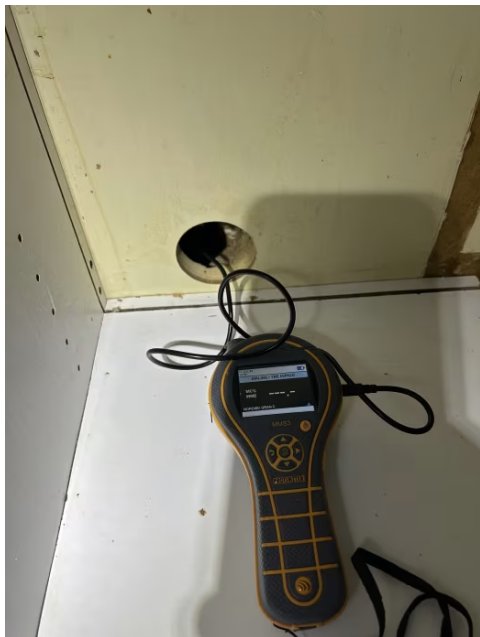
Hulltaking i tilstøtende vegg.
