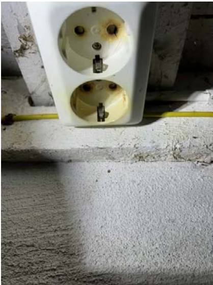
Brunsvidd støpsel til bereder.
