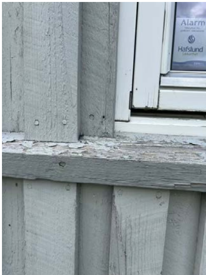
Treverk helt ned til vannbrett.
