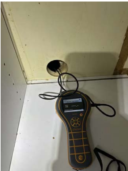
Hulltaking i tilstøtende vegg.
