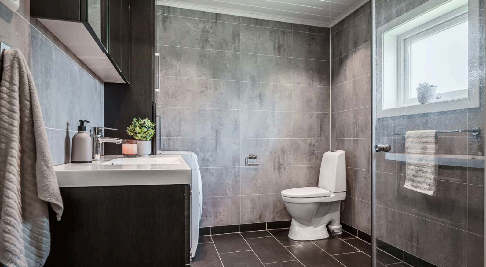
Moderne baderom oppusset i 2020. Baderommet har mørke fliser på gulv med gulvvarme, våtromsplater på veggene og downlights i himlingen.
