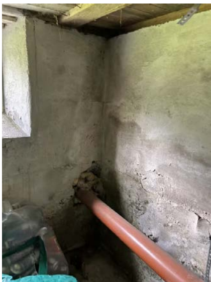
Ikke tett et ordentlig etter oppgradering.
