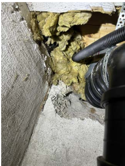
Ikke tett et ordentlig etter oppgradering.
