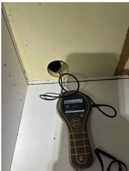
Hulltaking i tilstøtende vegg.
