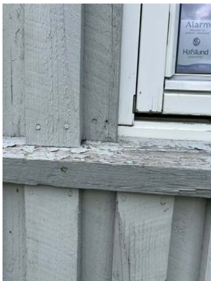
Treverk helt ned til vannbrett.
