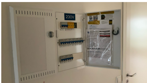
El-anlegg med automatsikringer. I hovedsak skjult ledningsnett. Sikringsskapet er plassert i entre/gang.
