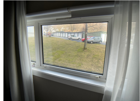
Vinduer på soverom datert 1992
