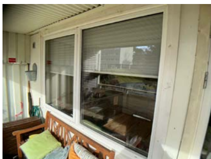
Vinduer i stue/kjøkken datert 1997
