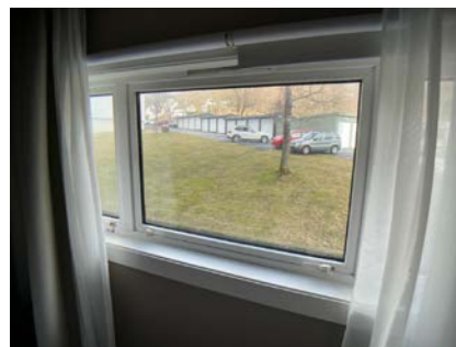
Vinduer på soverom datert 1992
