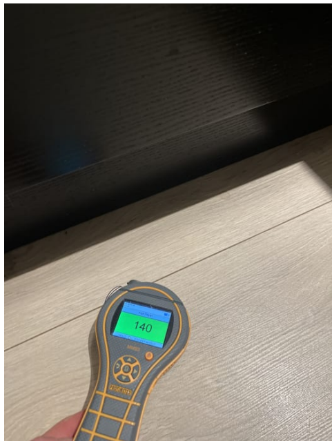
Ingen indikasjon på fukt i/rundt kjøkken
