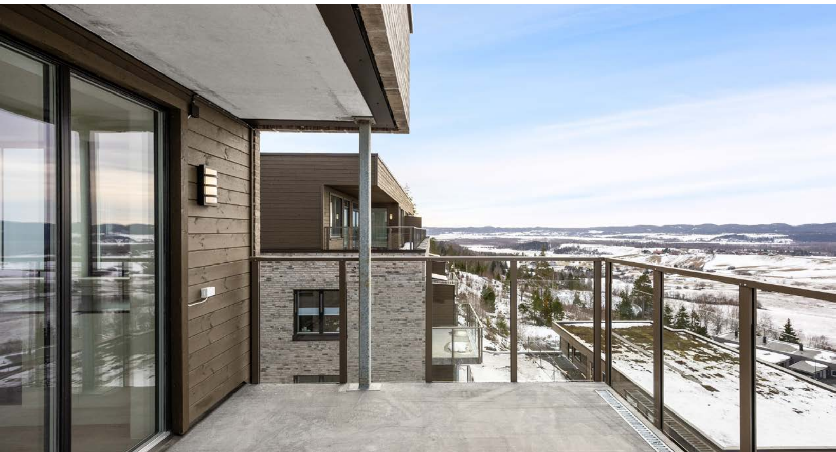
Ute på balkongen er det både belysning og stikkontakt.
