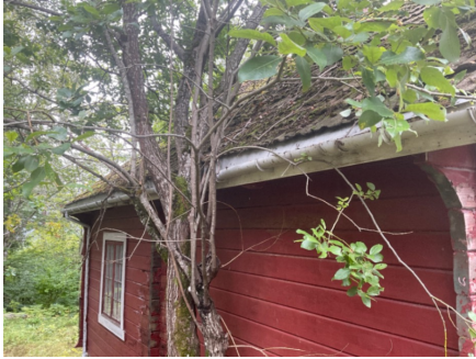
Takrenner og nedløp
