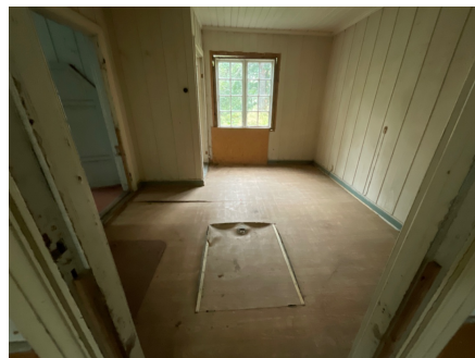
Innvendige overflater med høy slitasjegrad.
