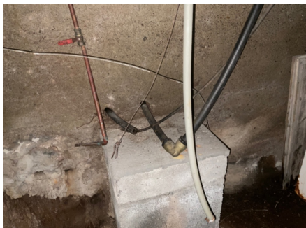
Hovedvannledning i plast
