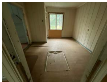
Innvendige overflater med høy slitasjegrad.
