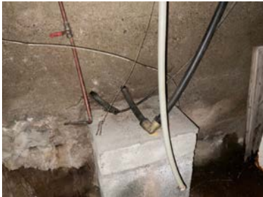
Hovedvannledning i plast
