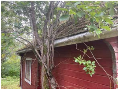
Takrenner og nedløp
