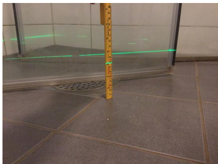
Kontroll av fall til sluk.
