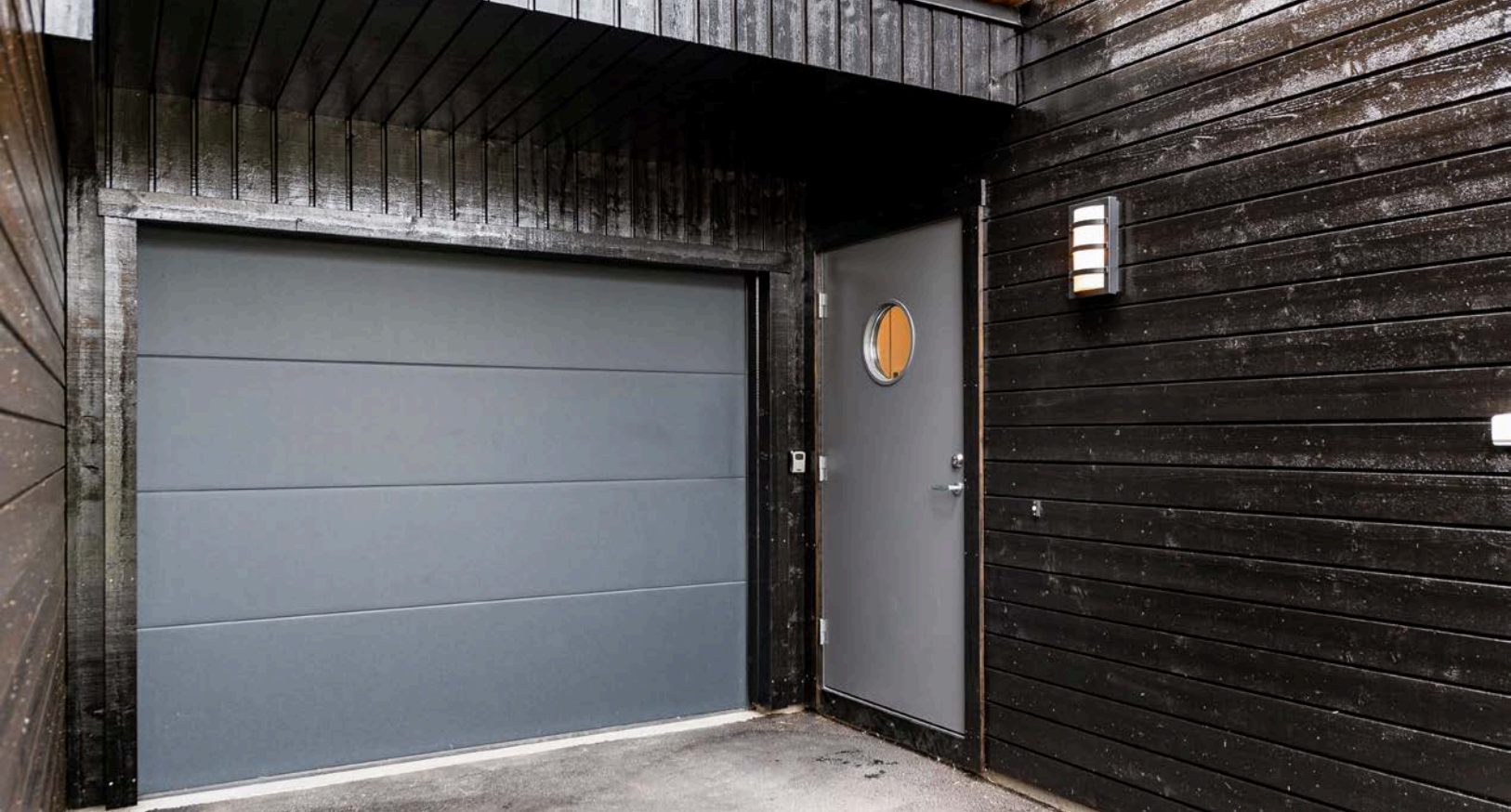
Asfaltert inngangsparti og garasje med elektrisk leddport. Montert utebelysning og kodeboks på vegg.
