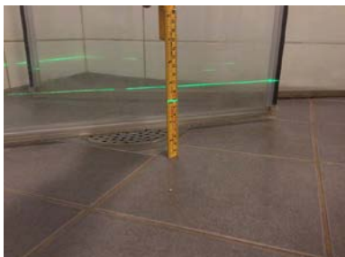
Kontroll av fall til sluk.
