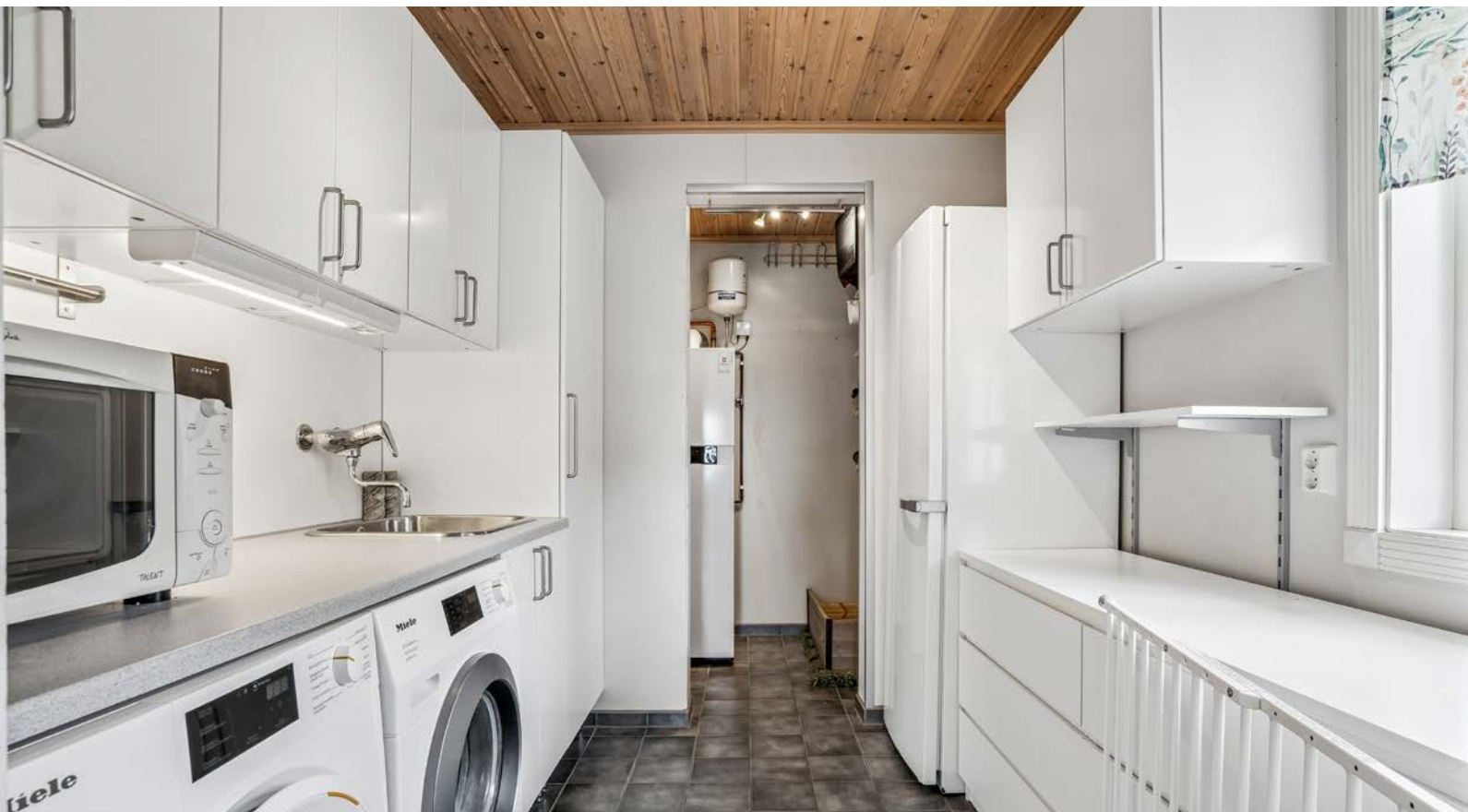
Praktisk vaskerom med innholdsrik innredning. Innenfor ligger teknisk rom med fyrkjele m/VV bereder.
