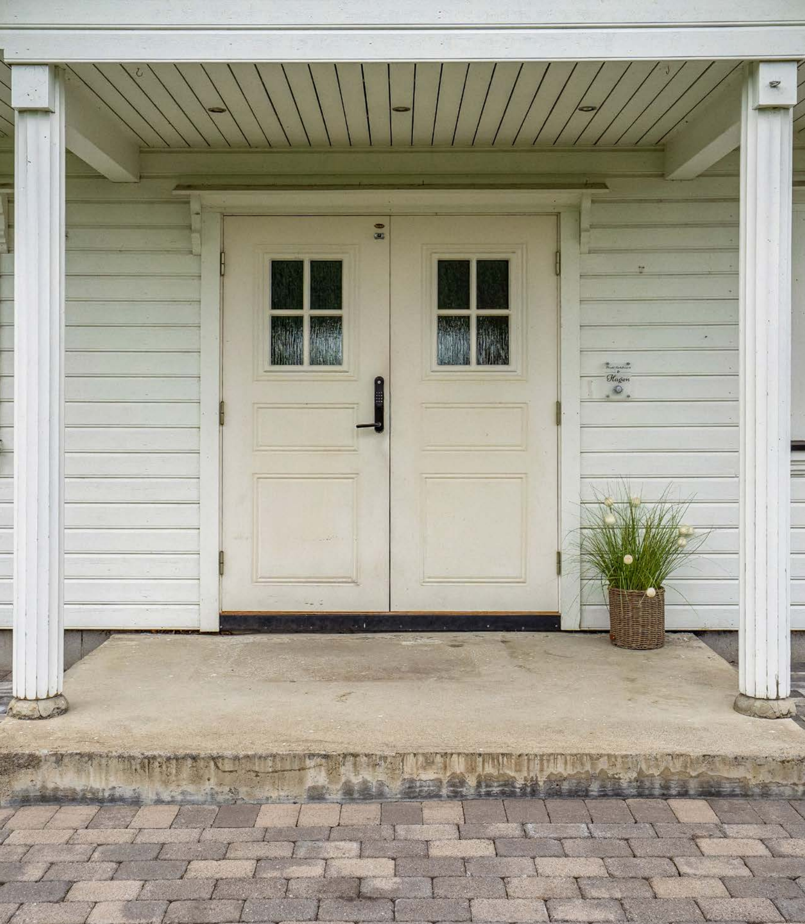
Takoverbygget inngangsparti og dobbel inngangsdør med Yale Doorman.
