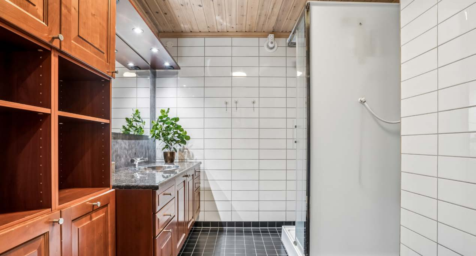
Bad v/hovedsoverom har fliser med varme i gulv og fliser og våtromsplater på vegger.
