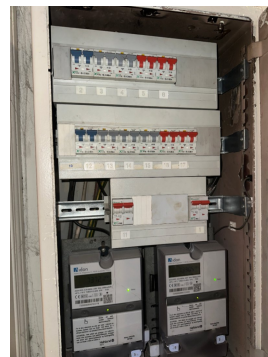
Sikringsskap med automatsikringer.
