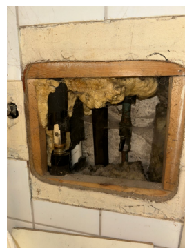
Rørapplegg under servant på bad.
