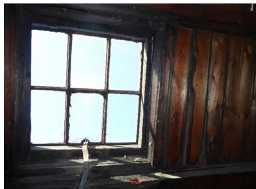
Eldre opprinnelig takluke på loft.
