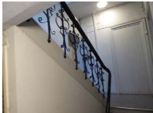
Rekkverk i smijern med håndløper i tre.
