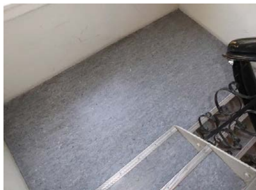
Belegg på repo i trappeoppgang.
