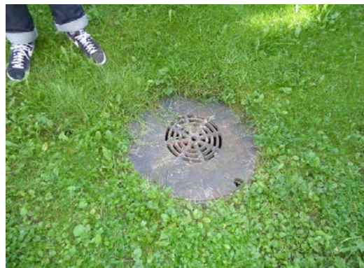
Overvannskum i bakhagen utenfor oppgang B.
