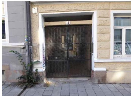
Port ved adkomst til eiendommen
