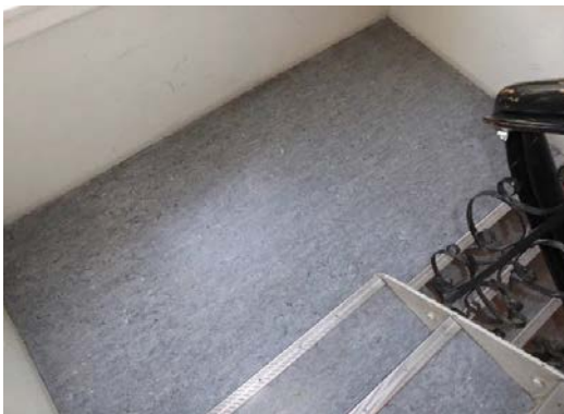
Belegg i trinn med trappeneser i aluminium som gir kontrast.
