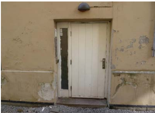
Dør til trappeoppgang
