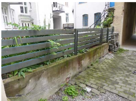
Støttemur med gjerde mot naboeiendom.
