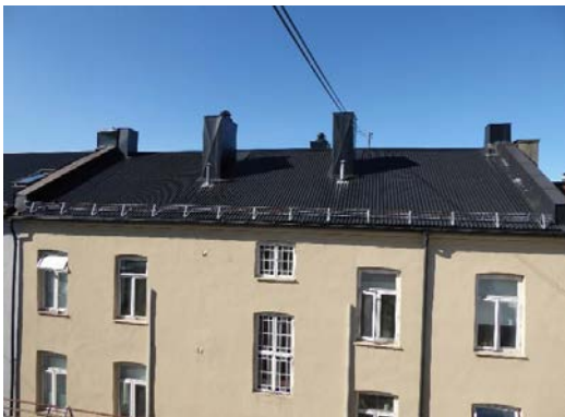
Taktekking med korrugerte plater, snøsikring og pipebeslag
