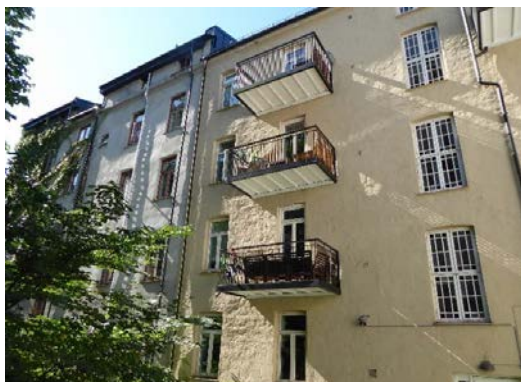
Tre av balkongene på bakgårdsbygget.
