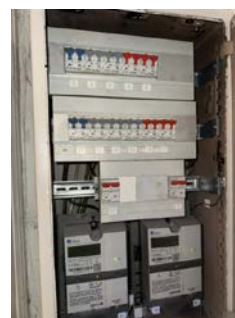
Sikringsskap med automatsikringer.
