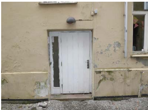
Lysarmatur over inngang oppgang A.
