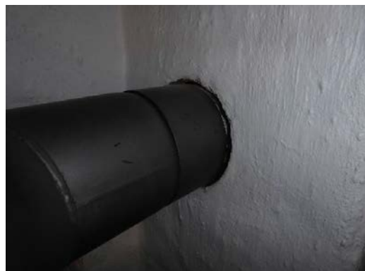
Røykrør montert vi røykrørføringsrør.
