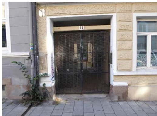
Port ved adkomst til eiendommen
