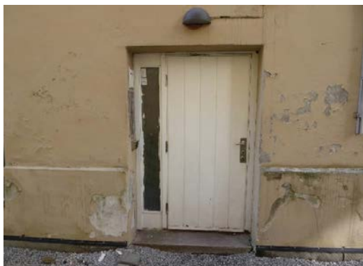
Dør til trappeoppgang
