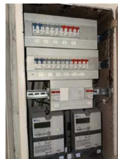
Sikringsskap med automatsikringer.
