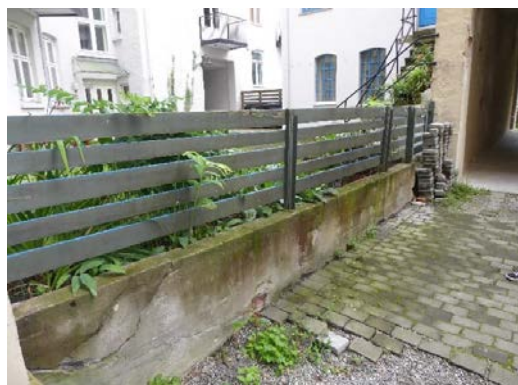
Støttemur med gjerde mot naboeiendom.
