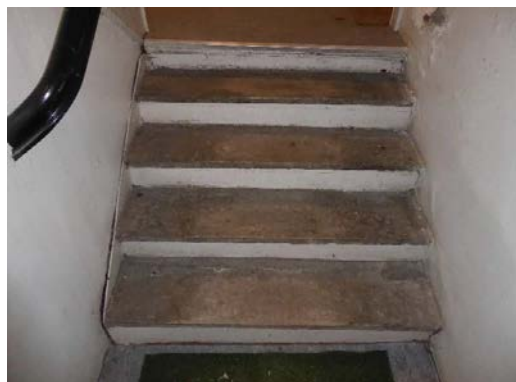
Trinn med skiferheller mellom 1. etasje og inngang i oppg. A.
