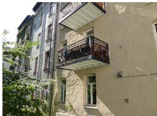
Rekkverk i stål.
