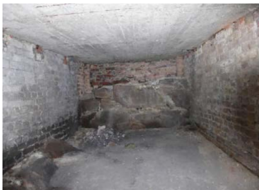
Vegger i kjeller. Yttervegg med naturstei/tegl innvendige teglvegger.
