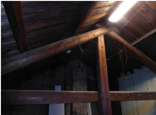
Bærende sperre/åskonstruksjon i tre.
