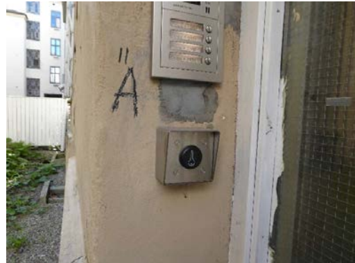
Brikkesensor for nøkkelfritt låssystem.
