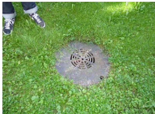
Overvannskum i bakhagen utenfor oppgang B.
