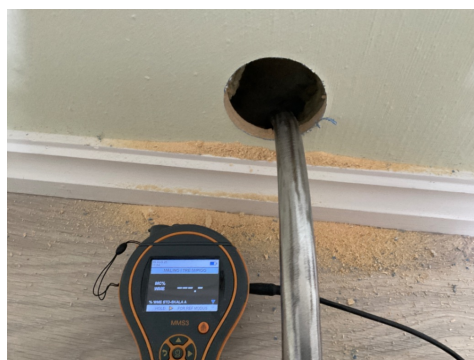
Hulltaking i 2.etg
