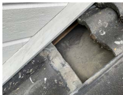
Undertak på høyre side av arken
