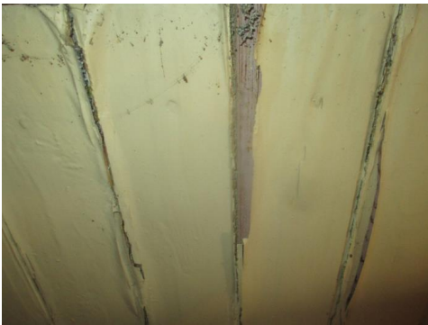
Yttervegg i trappoppgangen.
