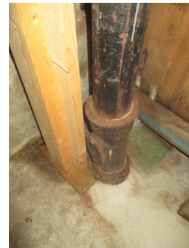
Eldre soilrør med stakeluke i kjellergulvet.
