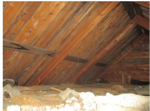
Deler av takkonstruksjonen.
