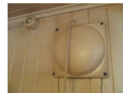
Eldre vifte i ytterveggen.
