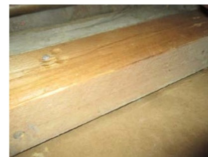
Fuktmåling i fra kottet som har åpen knevegg.
