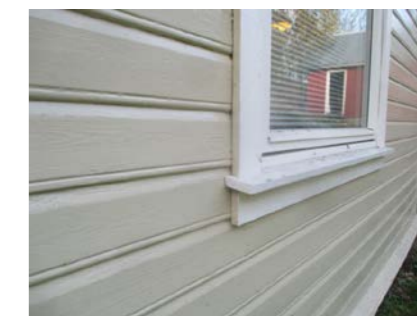
Deler av kledningen med tilhørende belistninger.
