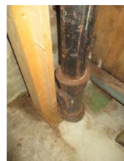
Eldre soilrør med stakeluke i kjellergulvet.
