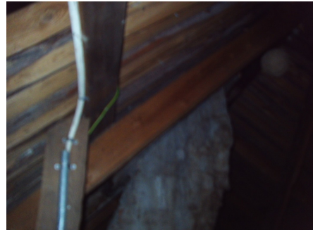
Deler av takkonstruksjonen.
