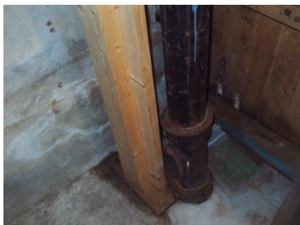
Eldre soilrør i kjellergulvet.
