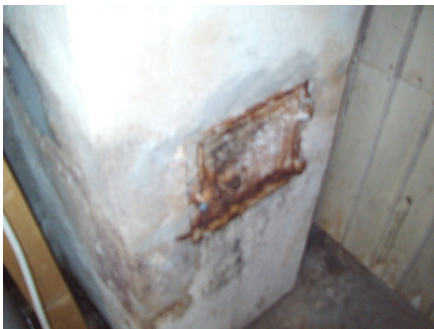
Sotluke i grovkjeller.
