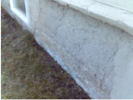
Deler av grunnmur.
