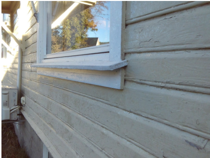
Deler av kledningen med tilhørende belistninger.
