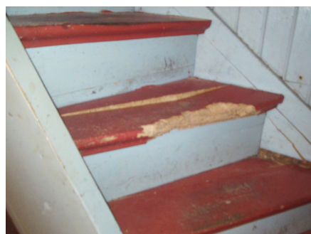
Trapp angrepet av stripet borebiller.
