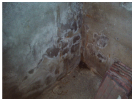
En del fuktmerker på grunnmur.
