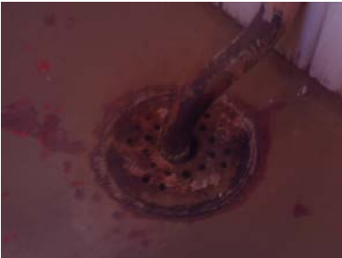
Eldre støpejernsluk
