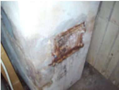
Sotluke i grovkjeller.
