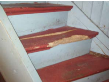
Trapp angrepet av stripet borebiller.
