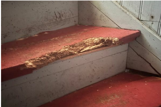
Kjellertrapp er spist i stykker
