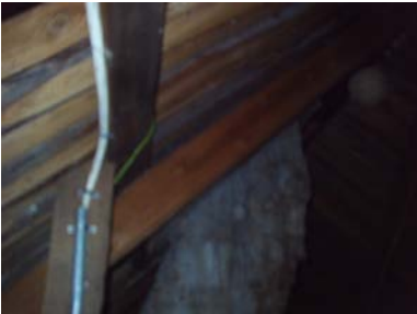
Deler av takkonstruksjonen.
