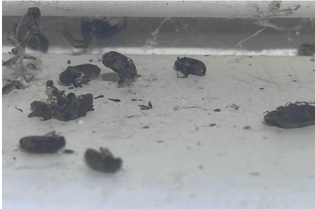
Borebiller i vinduskarm
