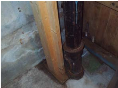
Eldre soilrør i kjellergulvet.
