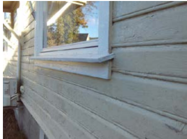
Deler av kledningen med tilhørende belistninger.
