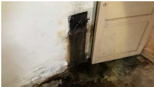
Feiluke i kjelle, med merker etter pipebrann i 2017
