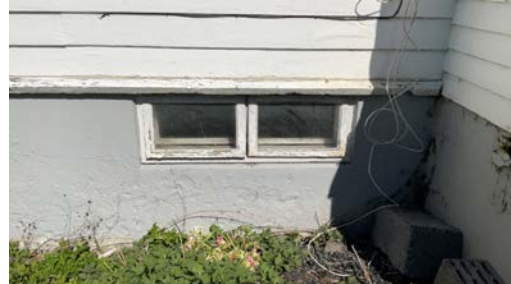
Vinduer i kjeller fra byggeår.
