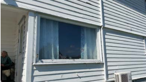
Vindu i stu 1. etasje fra byggeår.
