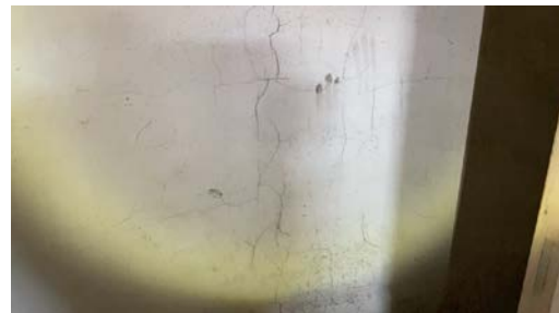
Det er påvist sprekker og/eller riss i pipe.
