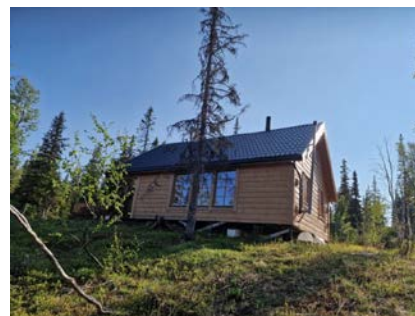
Tak sett fra Øst
