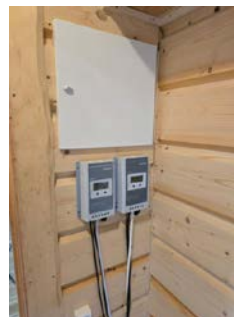
Sikringsskap og solsellepanel styring
