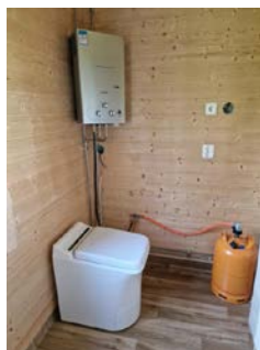
Bereder gassfyr, toalett forbrenning
