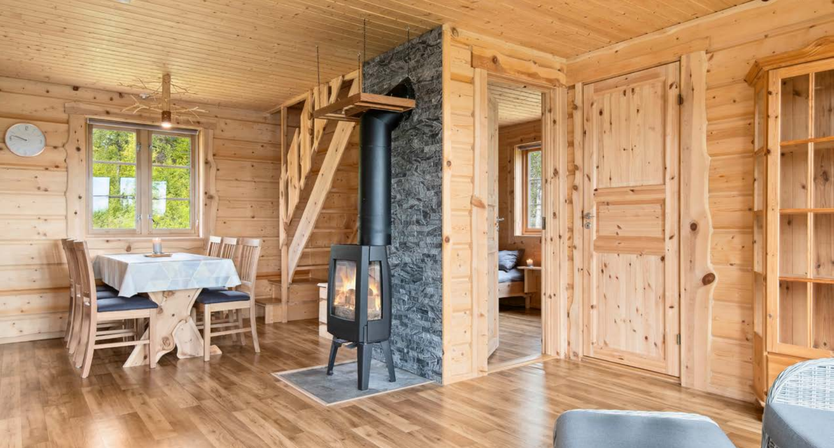
Vedovn med stålpipe og fasadeskifer bak ovnen.
