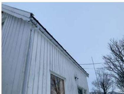
Eldre plastrenner på hovedbygg mot sør.
