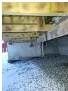
Oppe til høyre i bilde er det muggdannelser i betong.
