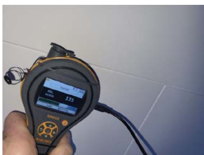
Fuktsøk i himling. Ingen forhøyede fuktverdier påvist.
