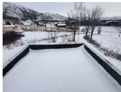
Utvendig taktekke var snødekt på befaringdagen.
