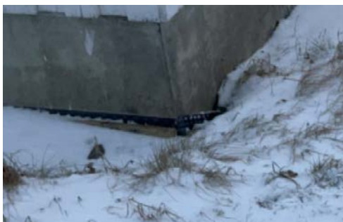
Grunnmur mot nord med grunnmursplast.
