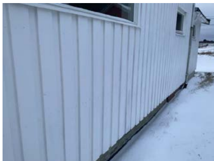
Kledning fra 2017 mot nord.
