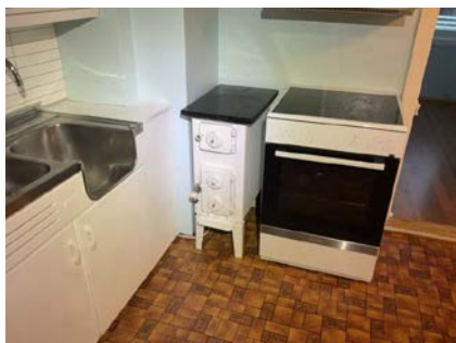
Vedovn på kjøkken med brennbare materialer på vegg nærmere enn 30 cm.
