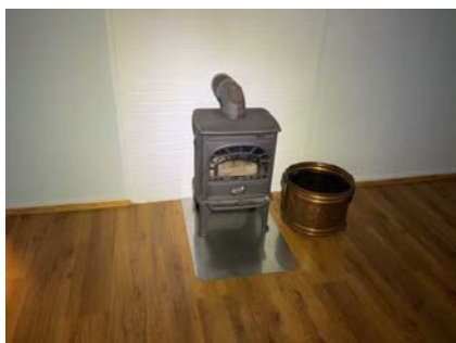
Vedovn på kjøkken med brennbare materialer på vegg nærmere enn 30 cm.
