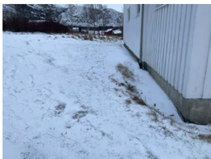
Fall inn mot bygning mot nord.
