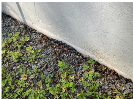
Platonplast på deler av grunnmur.
