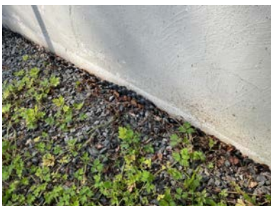
Platonplast på deler av grunnmur.
