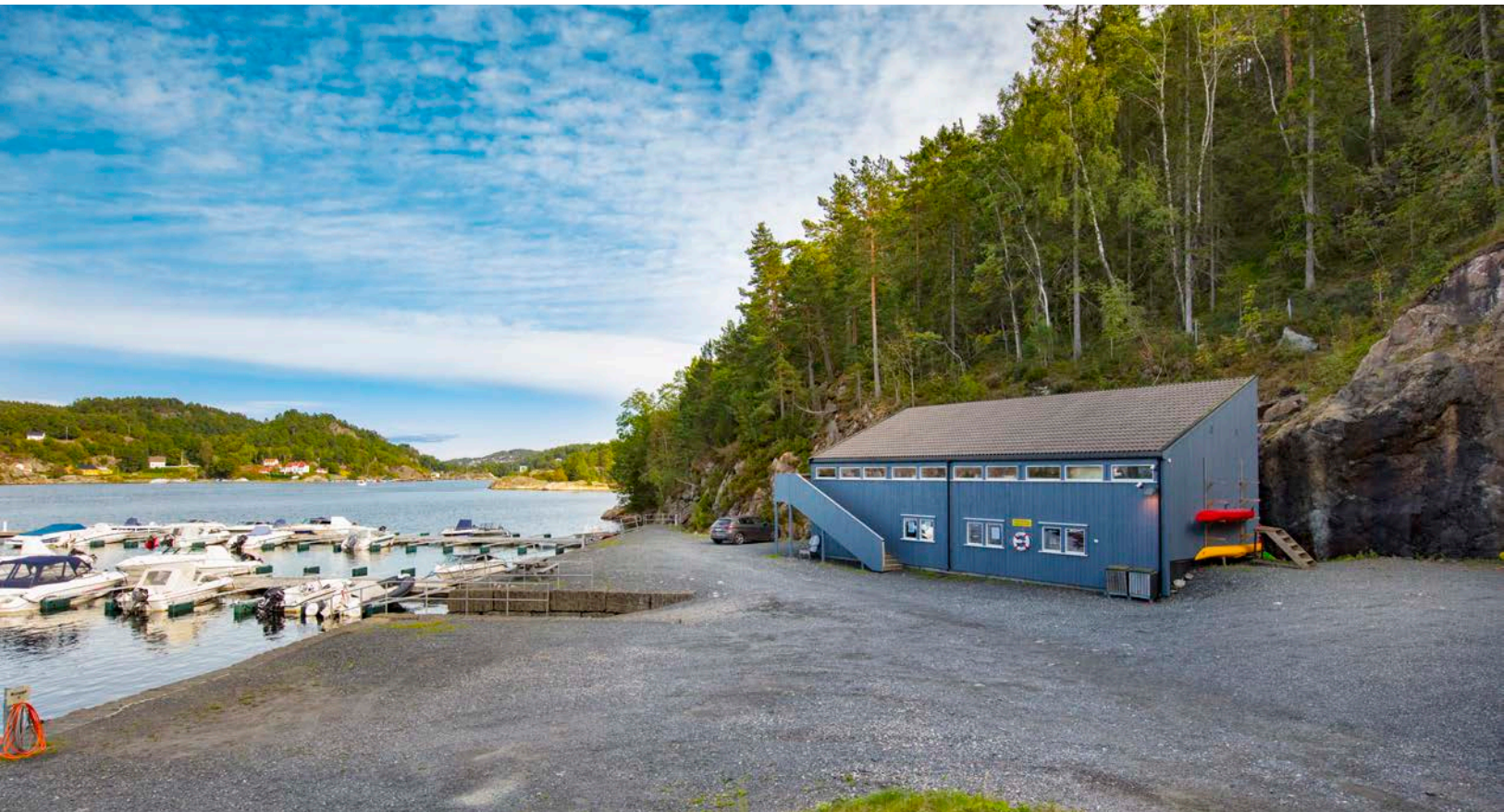
Felles bryggeanlegg med tilhørende båtplass
